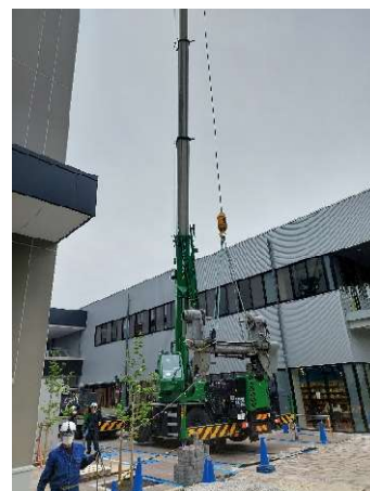
図 4. クレーンで搬送中
