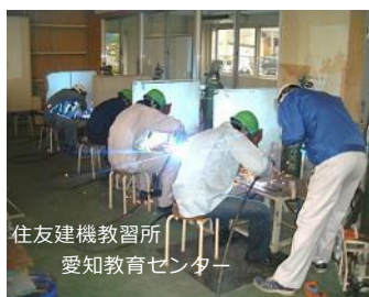
図 12. 被覆アーク溶接の様子 [3]
